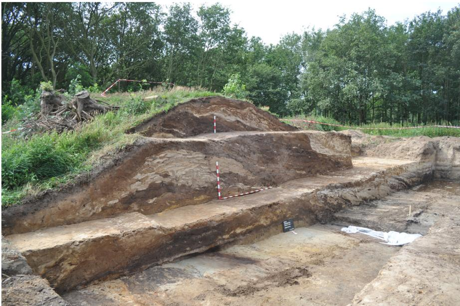
Abb. 1: Diele. Blick von der Schützenstraße auf den Profilschnitt durch den Deich mit den erkennbaren drei Bauphasen. In der rechten Bildhälfte sind im unteren Profilschnitt die Schwemmschichtabfolgen erkennbar, auf die der jüngere Deich aufbaut. (Foto: A. Hüser)
